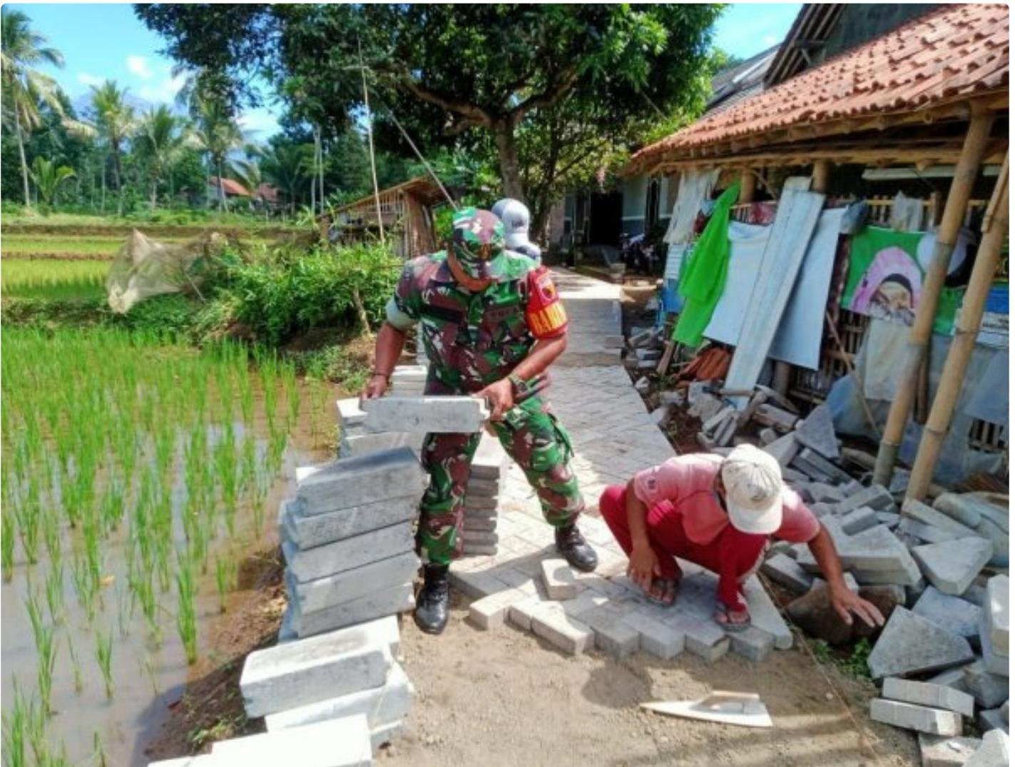
JEMBER – Pemasangan paving blok di jalan pemukiman warga dengan ukuran lebar 1,5 meter dan panjang 100 meter dilakukan dengan kerja bakti warga, mengetahui hal tersebut Babinsa Selodakon Koramil 0824/16 Tanggul langsung turun tangan membantu percepatan pengerjaan. Pada Selasa 19/12/2023.
